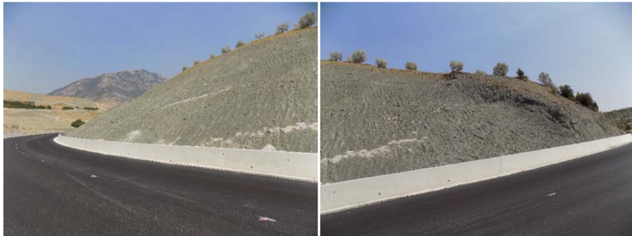
Figure 54 Foto: km 22+323.63 deri ne km 22+450 me shkembinjte Flishore (Argjilite, Alevrolite, Ranore).
