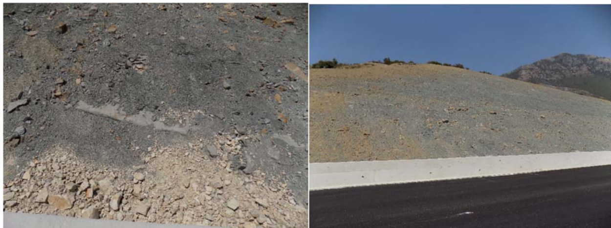
Figure 50 Foto: km 21+650 deri ne km 22+100 me shkembinjte Flishore (Argjilite, Alevrolite, Ranore) dhe filtrimet e ujit.
