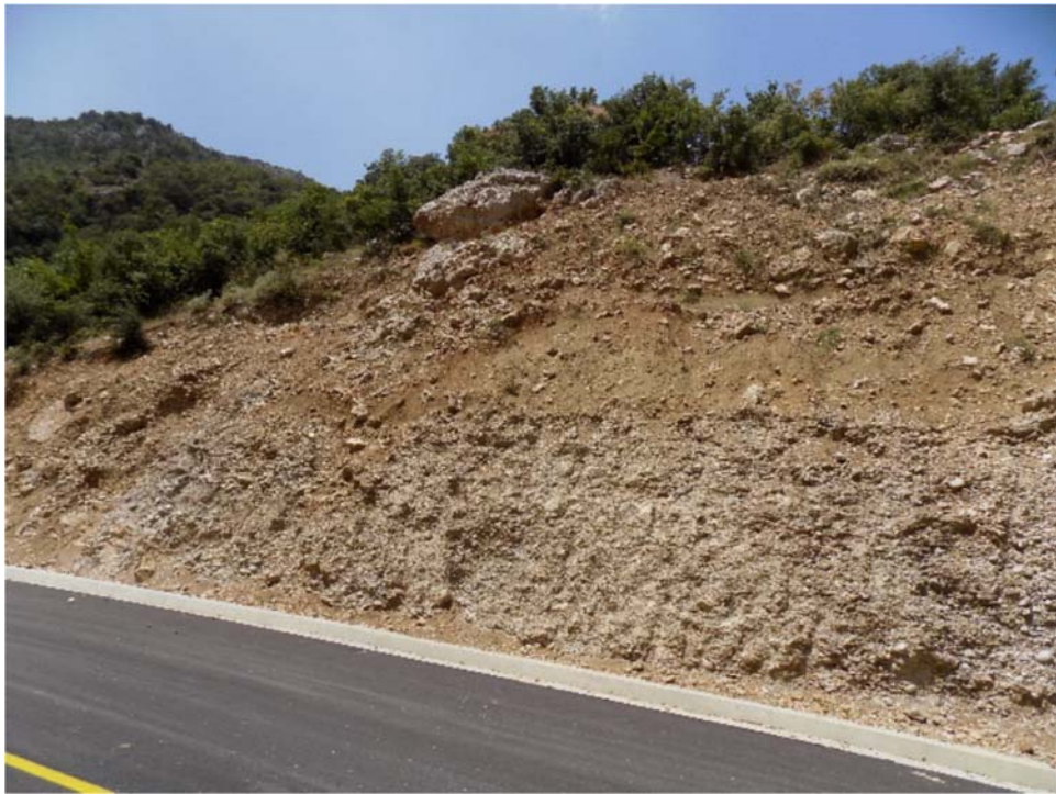
Figure 14 Foto ne terren nga Km 8+150-8+225
