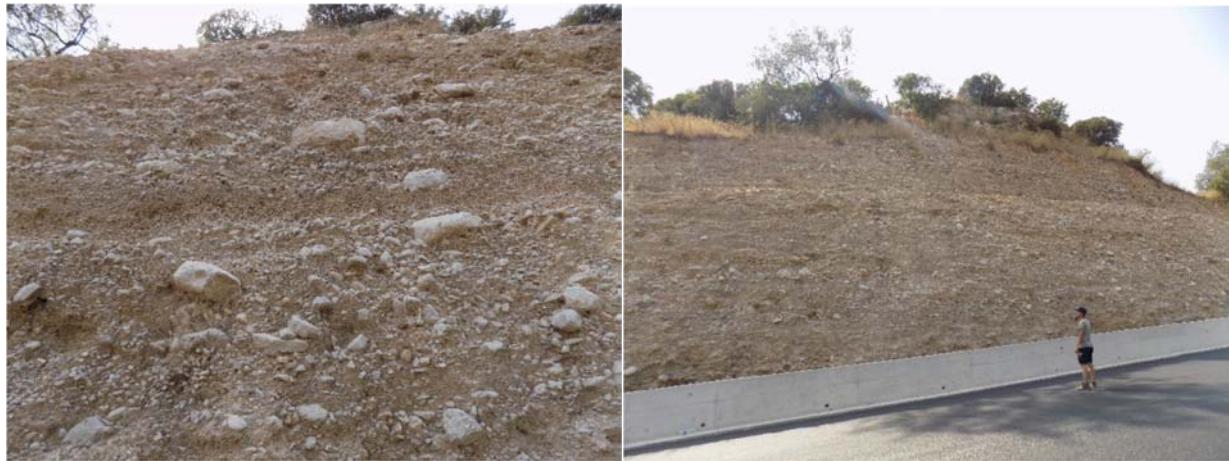
Figure 55 Foto: km 22+865 deri në km 23+032.66 Depozitimet zhavorrore mbi ato Flishore.
